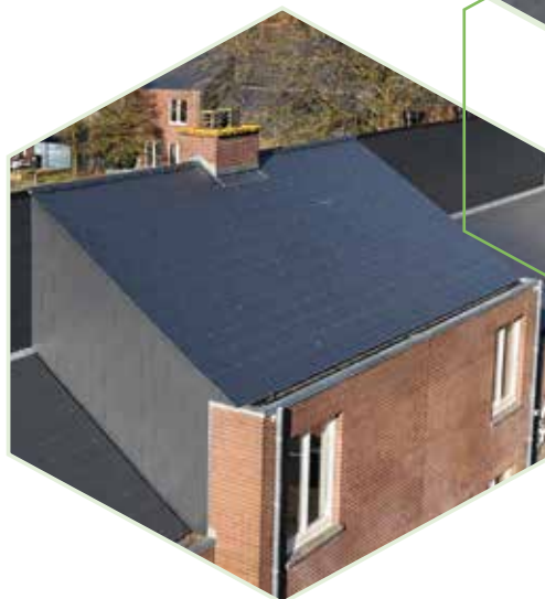
Foto's: Dakrenovaties Kerkhovenakkerlaan / Van Ostaeyenlaan
